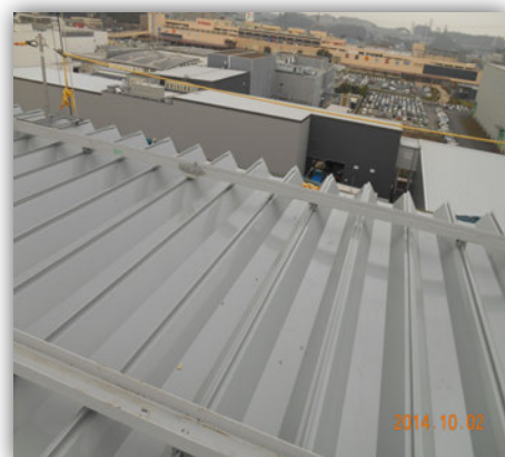
②【屋上走行レール】
