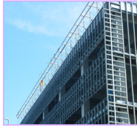
1 【外観揚重機設置】
