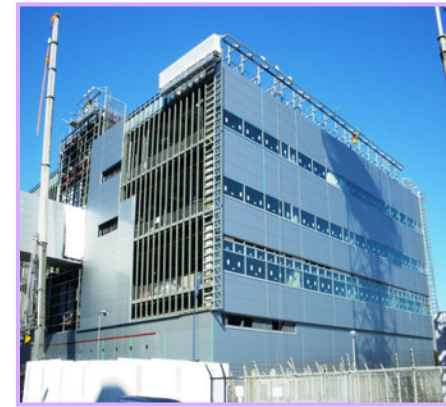
10 【SDパネル取付完成】
