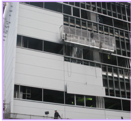
7 【SDパネル揚重中】
