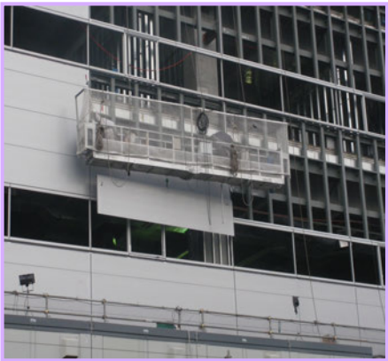
8 【SDパネル揚重中】
