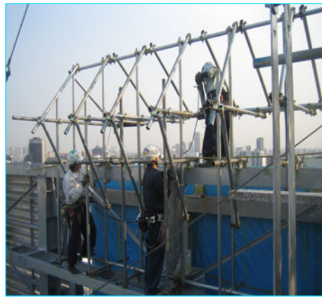
① 【屋上 架台組立】
