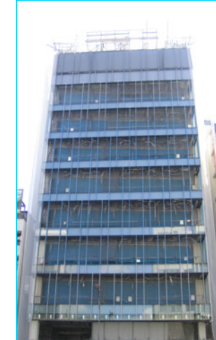
⑪ 【ガラス設置完了】
