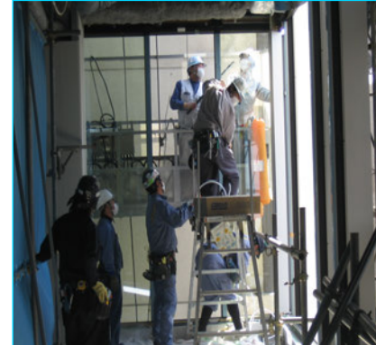
⑨ 【ガラス取付中】
