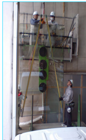
⑦ 【ガラス自重450K揚重中】
