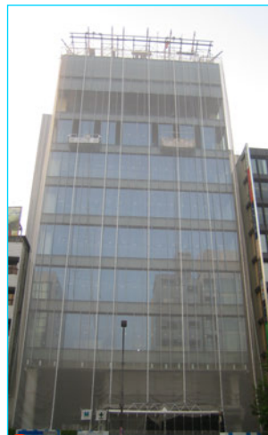
⑥ 【ネットイン工法】
