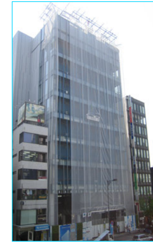
⑤ 【飛散・落下防止措置 ネットイン工法】
