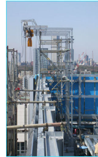
④ 【吊元架台完成 揚重機設置】
