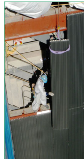
7 【外装材揚重中】
