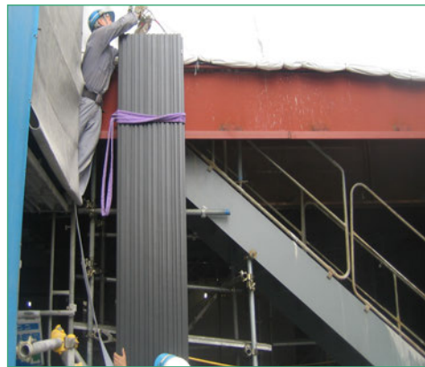
6 【外装材揚重中】
