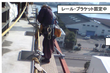
レールブラケット取付完了
