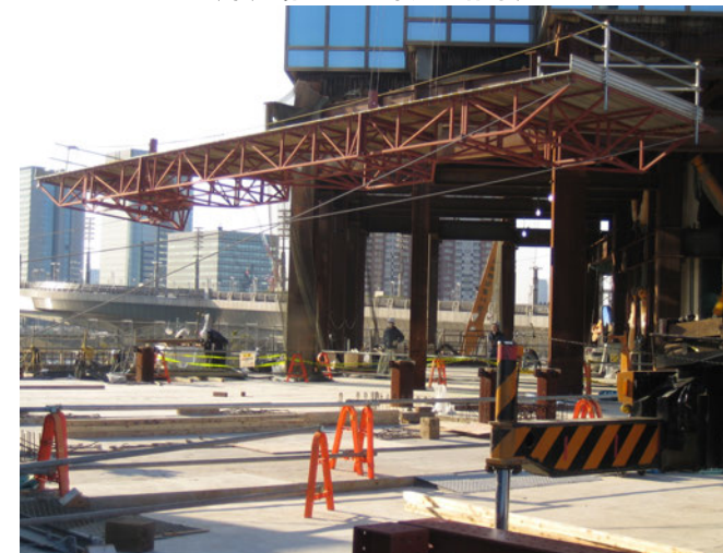
〈吊足場ユニット吊込み作業〉
