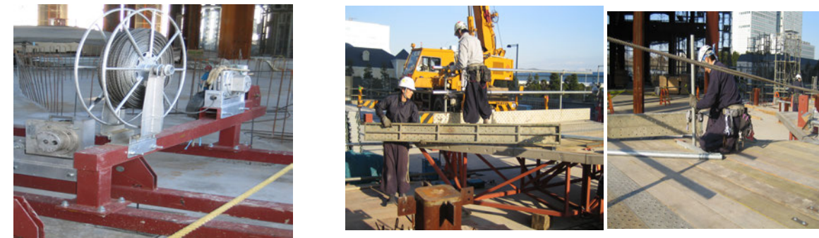
〈吊元装置組立〉
