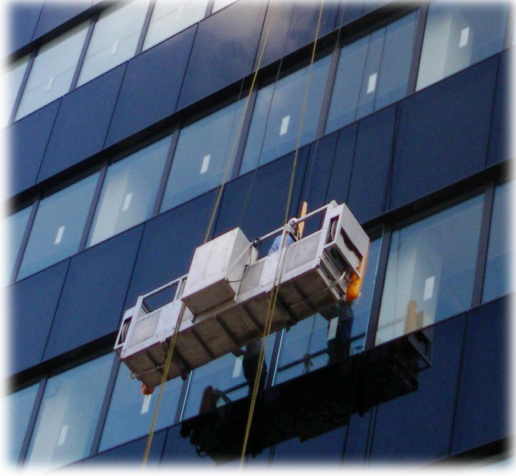
外部仕上工事
