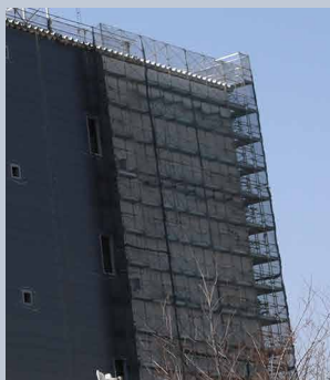
総枠組み足場の場合
