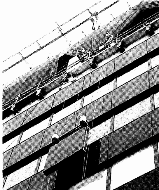
クレーンを使わず資材を荷揚げする揚重機システム
