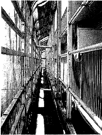
2階部分の内部
