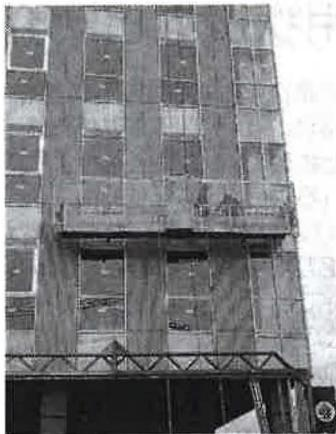
用し、外壁材の揚重から取り付け、仕上げ工事までを一貫して行うことができる。揚重機は無線操作で上下左右へ同時操作でき、最大で約80tの高さまでカバーできる。今回採用されたのは長崎食
