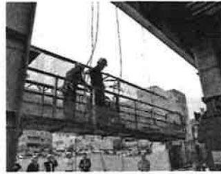
デッキ型ゴンドラと揚重機(複合主体)を併用し外装材の揚重から取付け、仕上げ工事までを一貫して行うシステム。外装材を取り付ける際のタワークレーンや重機等を使用し
