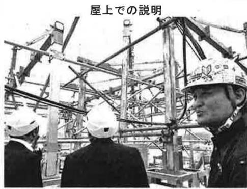
部にて▽吊元アーム▽ゴンドラ走行装置▽ゴンドラ走行レール▽揚重機走行レールを仮設。デッキ型ゴンドラを稼働させながら、並行して揚重機で外装材の吊り上げも可能とした。それにより、仕上げ工事までを一貫して進めることができるシ
