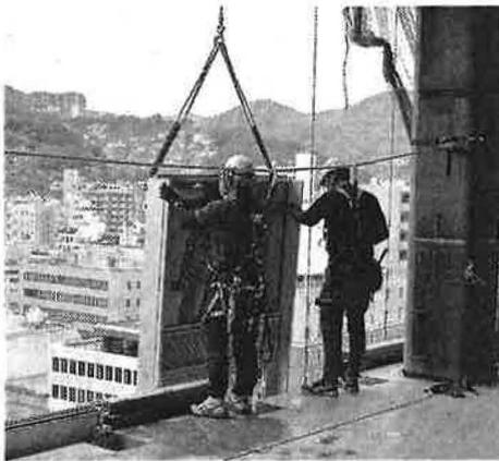
日綜産業グループの日綜ゴンドラが開発した「PUP工法/台車仕様」パネル揚重機システムが、九州で初めて長崎市元船町で建設が進む長崎BiZPORT新築工事の現場で採用されている。無足場のため足場の
