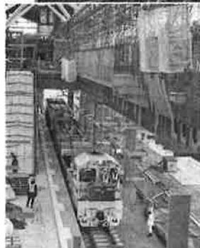
高輪ゲートウェイ駅大屋根部(上)と稼働中のパネル揚重機システム「P-U-P工法」
