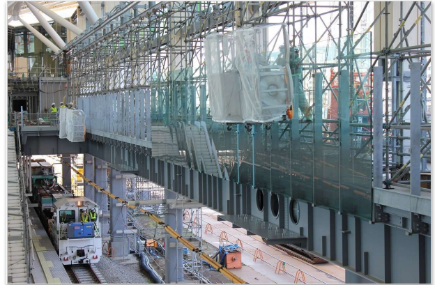
ゴンドラで作業している様子（撮影協力：JR東日本）
