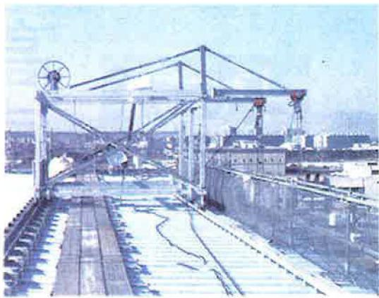
DPⅡ三郷Ⅱ新築工事現場で採用されているP-UP工法のゴンドラ①と屋上の折板二重葺屋根に設置された吊元アーム
