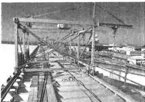
折半屋根に設置されたP-UP工法の吊元装置
